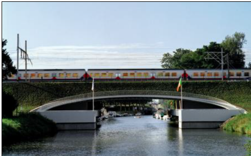
Onderbrugging “Snebrug” over de Leie
