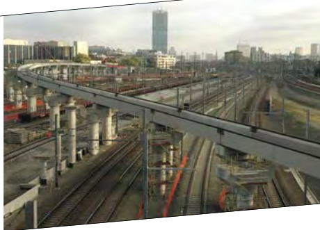
Plaatsen van het laatste onderdeel van het viaduct van Brussel-Zuid op 4 november 2005
