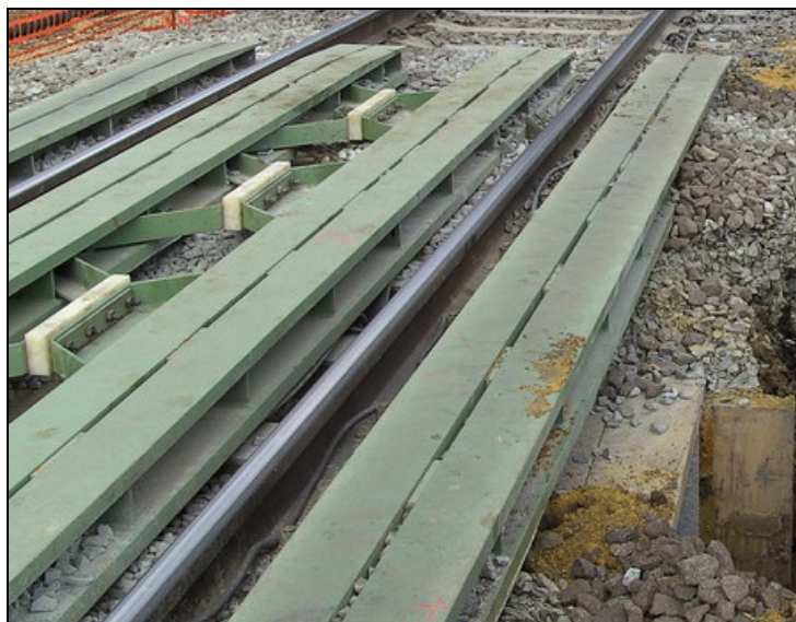
Figure 6 : Renforcement de voie de 7,20 m
