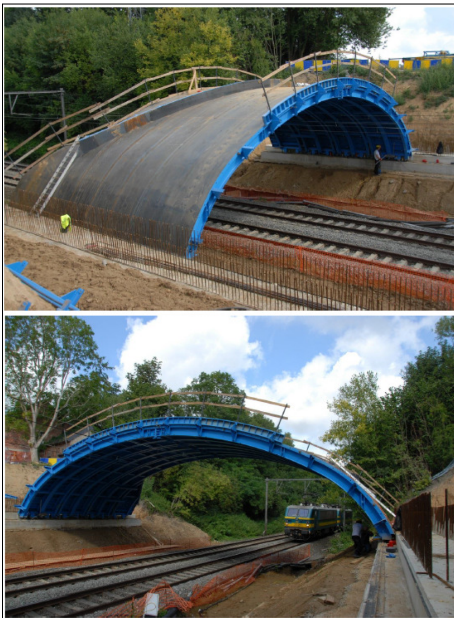
Figure 14: Coffrage en arc
