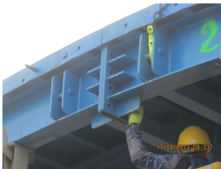
Assemblage des deux parties au moyen de boulons et écrous
