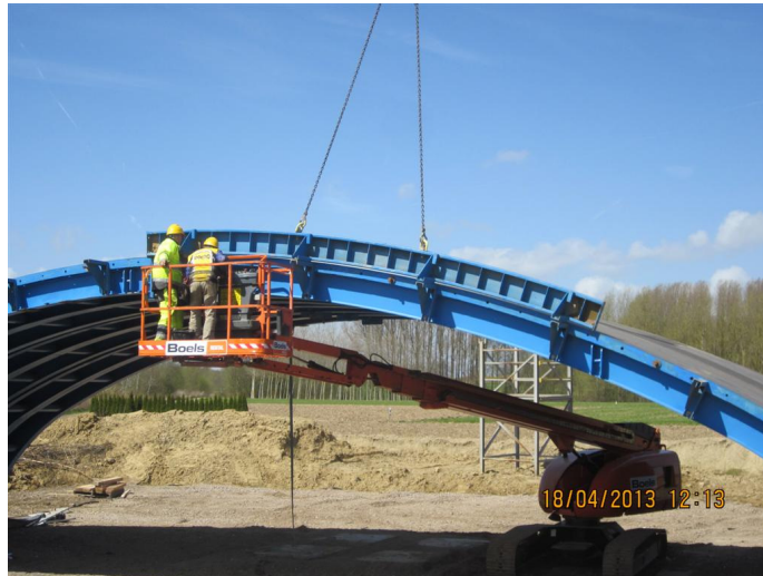
Montage de la partie supérieure du coffrage de bord
