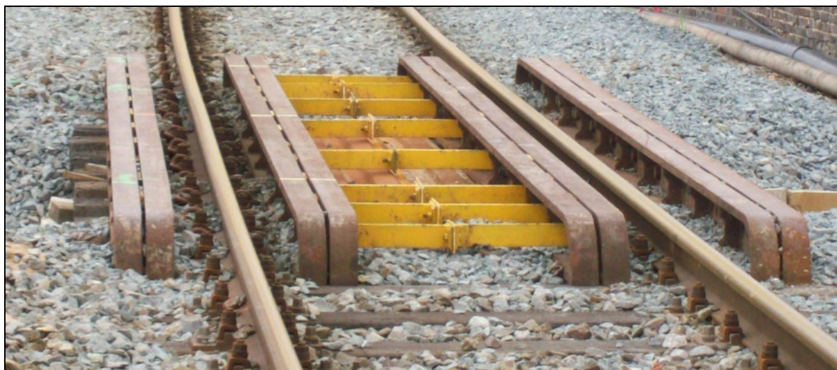
Figure 3 : Renforcement de voie de 7 m
