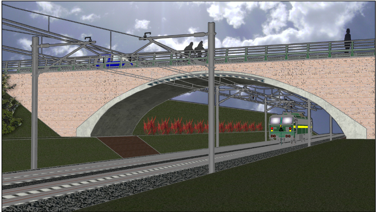
Figure 17: Pont-route avec murs verticaux en maçonnerie
