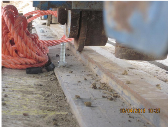
Positionnement du coffrage sur les rails de guidage
