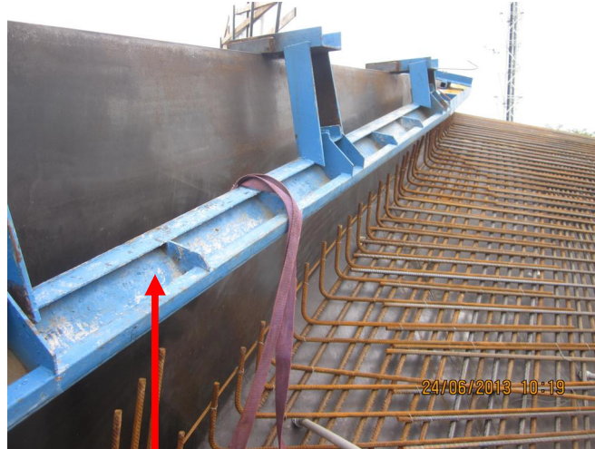
Coffrage supérieur pour mur de front.
