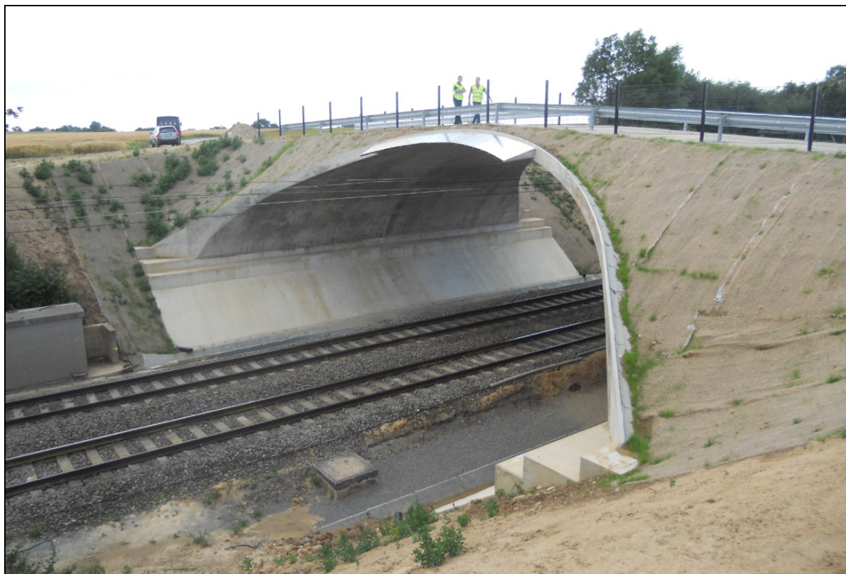
Figure 15: Pont-route avec talus au dessus de 2 voies
