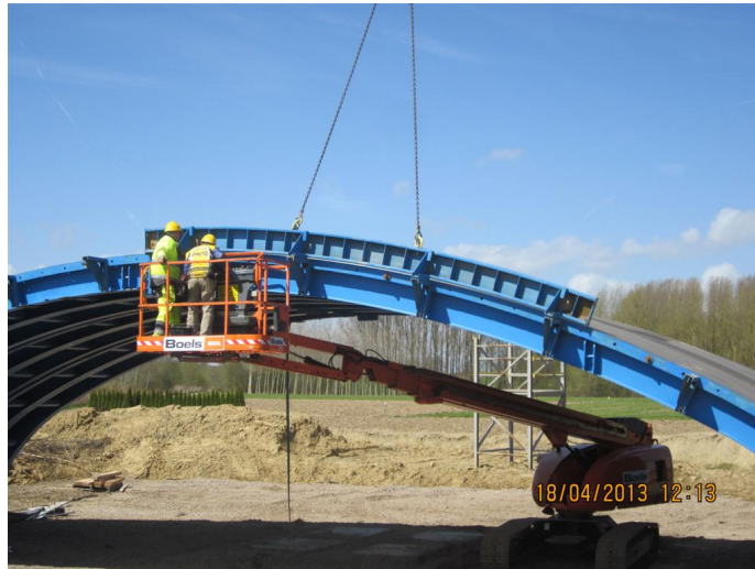
Montage bovenste gedeelte randkist
