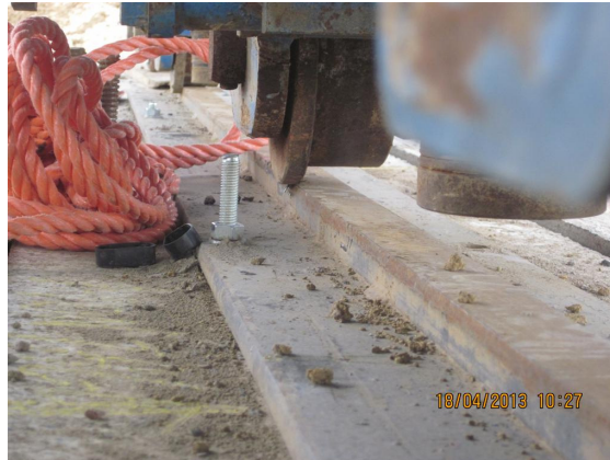
Positioneren van de bekisting op de geleiderails
