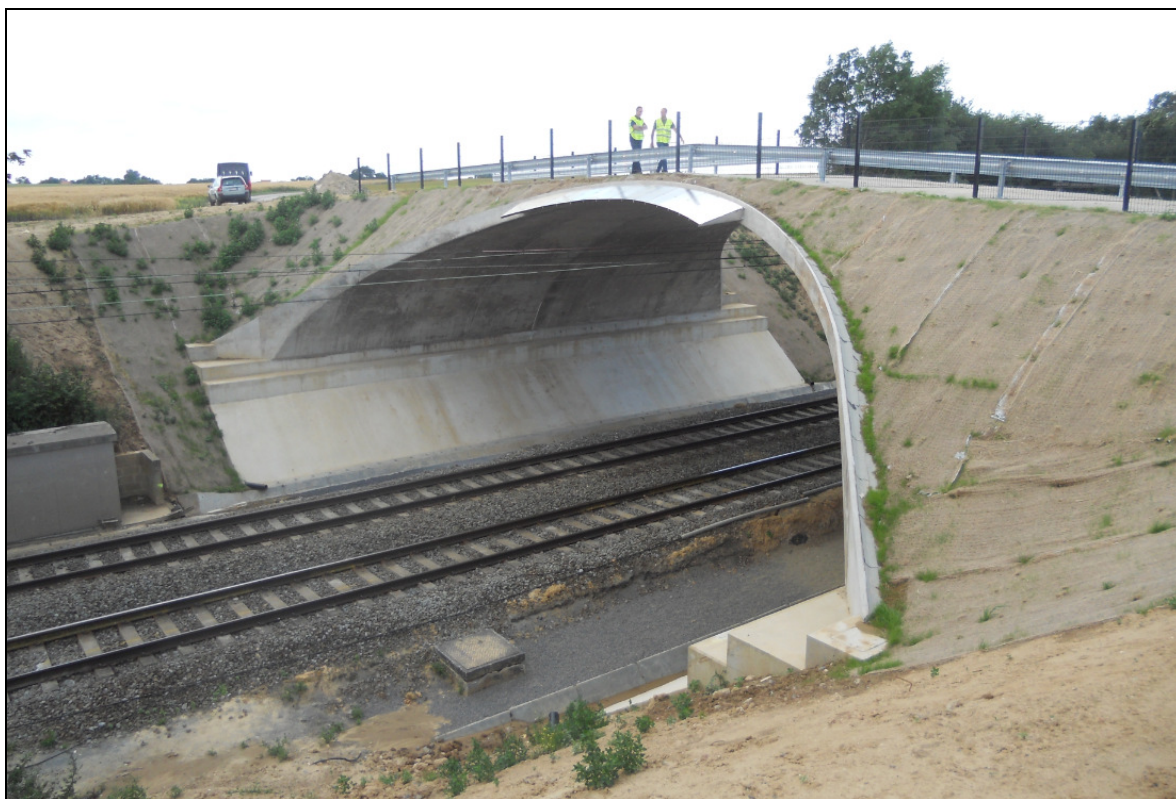
Figuur 15: Wegbrug met talud over een dubbel spoor
