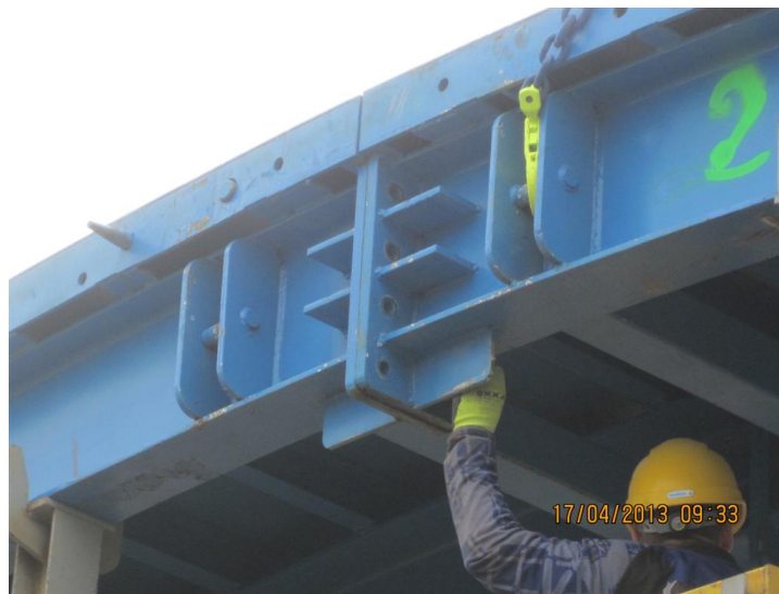
Bevestigen van de twee delen d.m.v. bouten en moeren
