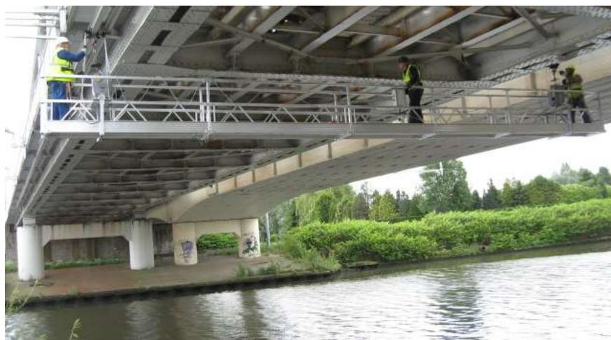
Figure 14.5 – Exemple de plate-forme de visite mobile
