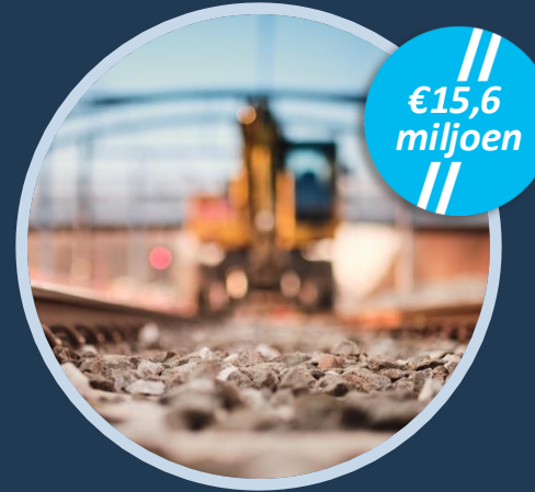
Aanleg tweede spoor tussen Mol en Neerpelt
