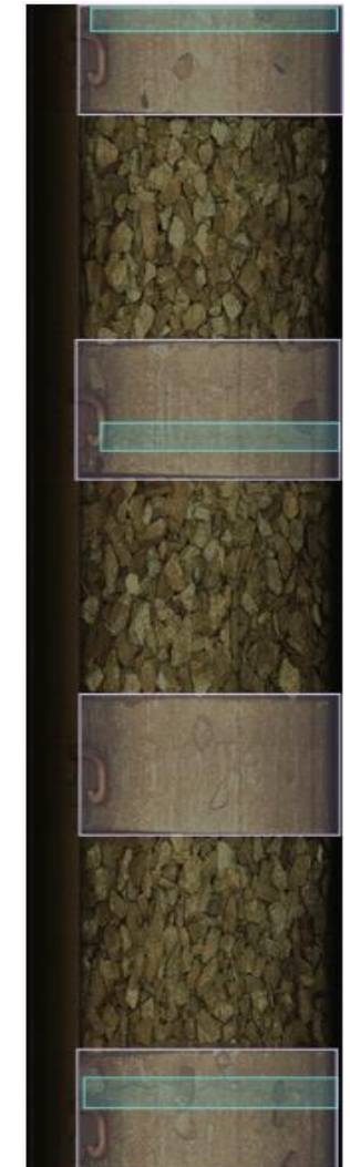
Vue du ballast
