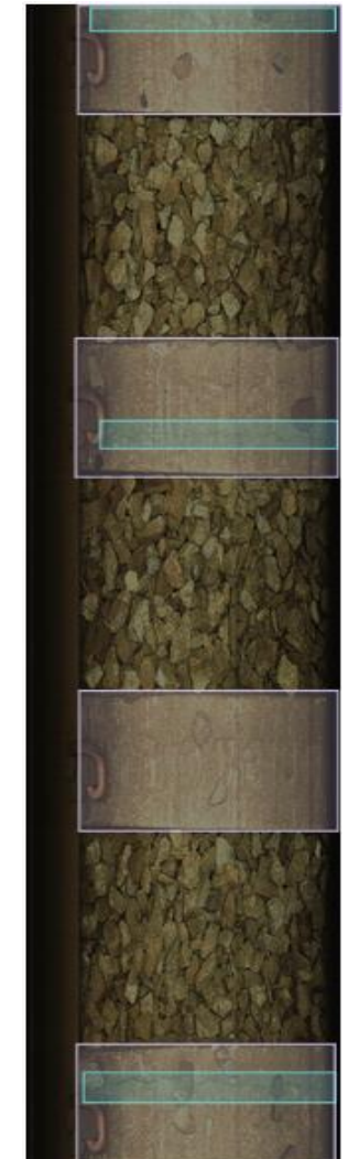
Aanzicht van het ballastbe
