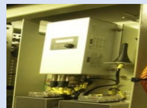
Mesure du courant et de la tension sur le toit. Mesure du courant autour d'un câble. Un compteur d'énergie.
